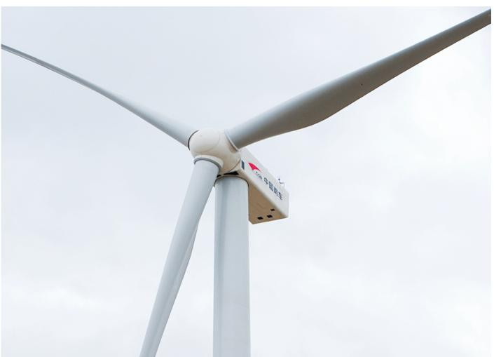
WT2500风力发电机组采用高速永磁同步发电机加全功率变流器设计方案,适用于沿海、内陆和潮间带等多种环境。
